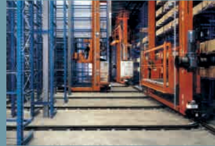
Transstockeurs sur rails lors d'un changement d'allée
