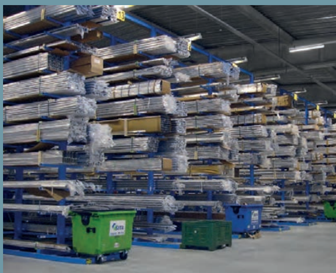
Système à voies étroites avec passerelle pour un entrepôt de profilés aluminium.
